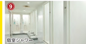
⑨ 個室シャワー
